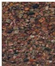
**Le rocaillage** teinté par de la brique pilée, dit « plein » dans lequel des éclats de meulière recouvrent totalement la maçonnerie.
