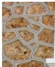
**Dans le jointoiment rubané**, les moellons sont entourés d'un joint saillant souligné d'un trait qui met en valeur leur irrégularité.
