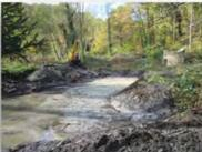
Un curage total a permis de récupérer un volume d'eau suffisant. La digue bétonnée a été supprimée, de manière à s'affranchir d'éventuelles pertes par infiltration. Les berges, façonnées en pente douce, permettront à la végétation typique des mares de se réinstaller progressivement en cercles concentriques.
