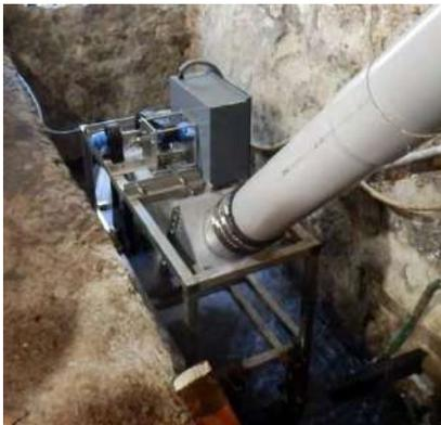
Il s'agit d'une expérimentation dans le cadre des Utopies Réalistes. Ce dispositif de production d'électricité de 1,5kW alimente le musée en autoconsommation.
