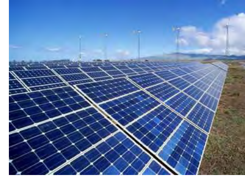
D - le solaire photovoltaïque
