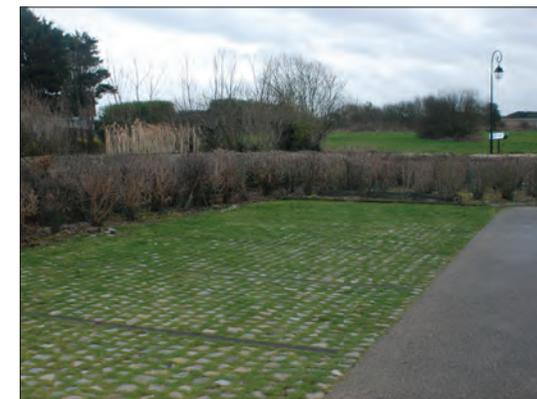
Exemples d'espaces de stationnements plantés : les emprises pour les voitures sont traitées en terre pierre enherbé, pavés à joints enherbés ou encore en grave naturelle. La grande place laissée au végétal permet de mieux intégrer au sein des villages, et de maintenir une perméabilité des sols.
