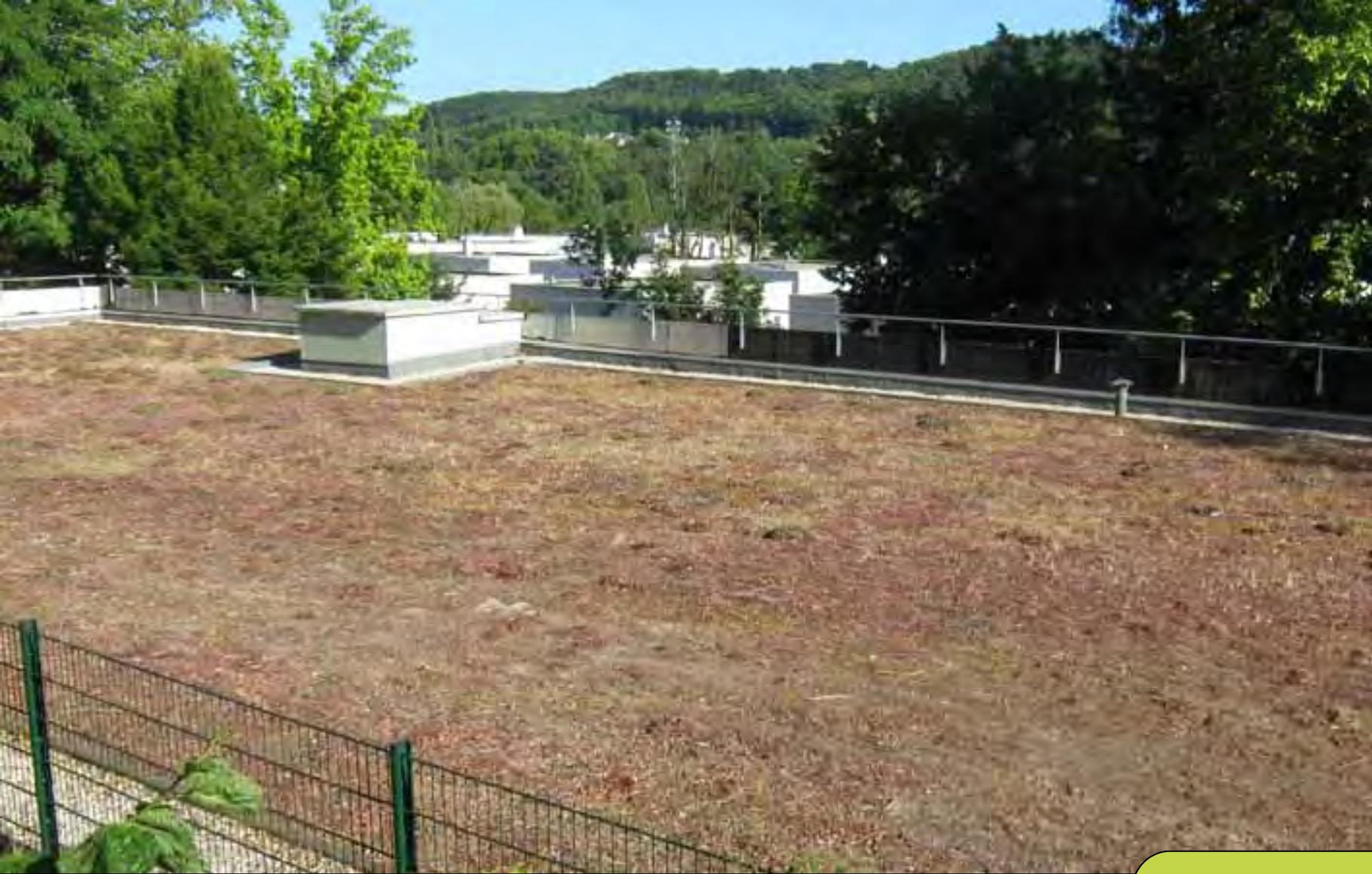
cinq toitures terrasses végétalisées (473 m<sup>2</sup>) intégrant des capteurs solaires (2.8m<sup>2</sup> au sol par logement) alignés et rendus invisibles de la rue et du coeur d'îlot par des garde-corps.
