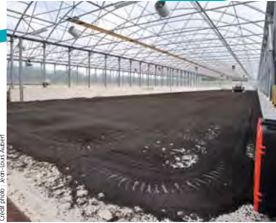
Séchage solaire des boues (Châteaulin, 29)
