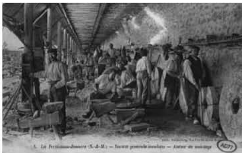
Assemblage des « carreaux » (fragments de pierres cerclés), une spécialisation des Molières puis du site de la Ferté-Sous-Jouarre (ci-dessus)
