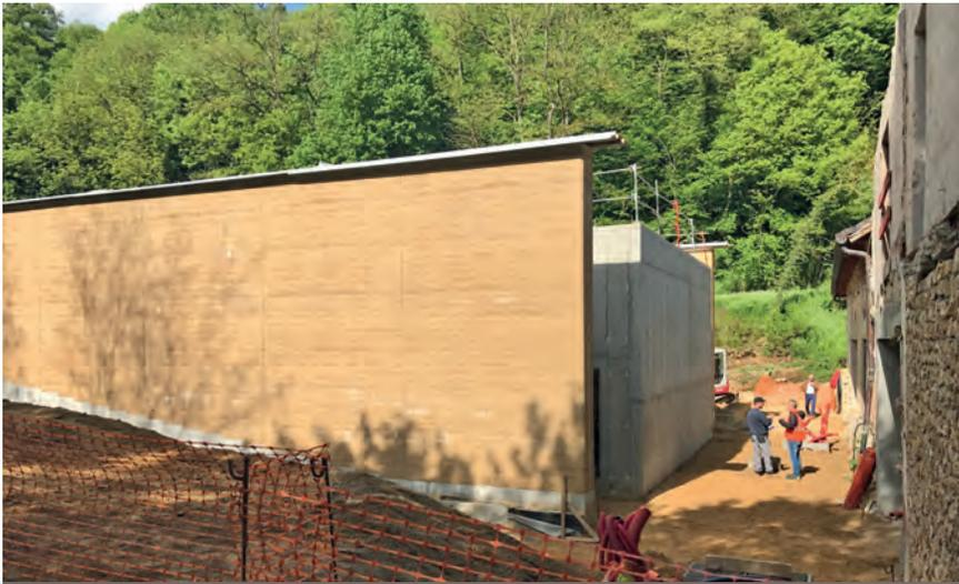
La construction des deux murs latéraux en pisé participe aux travaux d'intégration de ce bâtiment, avec l'avantage d'utiliser un matériau prélevé sur site diminuant notablement l'empreinte carbone de ce chantier.
