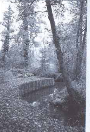
La consolidation des berges du ru des Vaux de Cernay, à Senlisse, par pieux jointifs.
