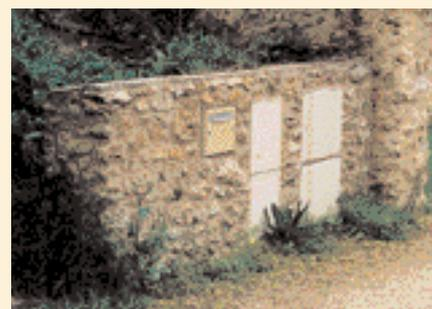
▲ Lors de la conception des clôtures il faut prévoir l'intégration des équipements techniques. On peut aussi placer les coffrets, en retrait dans le mur, derrière un portillon en bois en façade.
