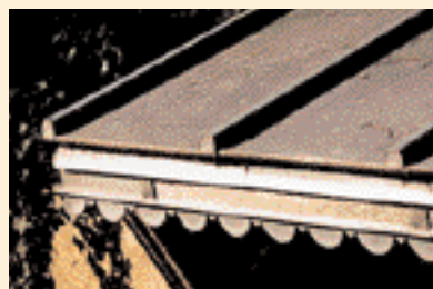
◀ Auvent en zinc d'un lavoir privé.
