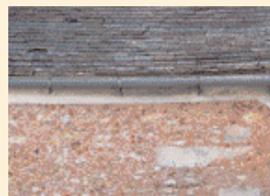
Enduit coloré à la brique pilée. ▼
