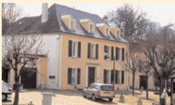
L'ardoise est adaptée aux fortes pentes. ▼
