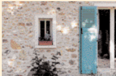
Enduit à pierre vue. ▲
