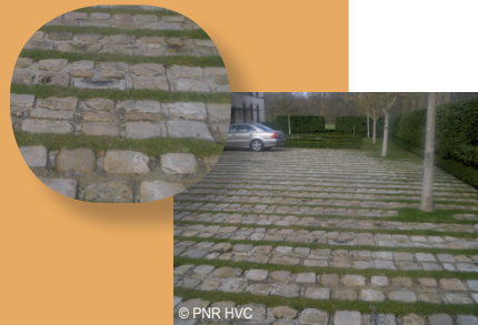
Une ligne d'herbe en alternance avec deux lignes de pavés qui permet l'infiltration des eaux de pluie et crée une élégante esthétique.
