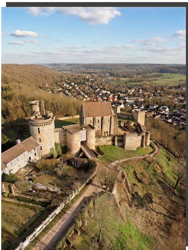
Vues aériennes du château de la Madeleine
