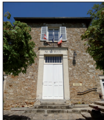
Façade entrée mairie, 2016
