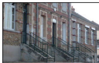
Côté cour arrière, 2012
