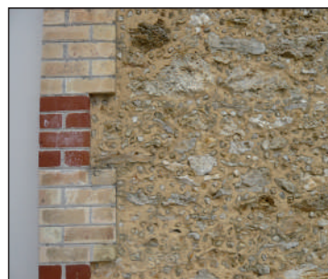
Détail du mur, 2016
