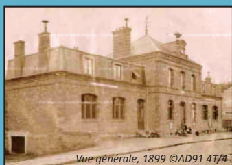
Vue générale, 1899 ©AD91 47/4
