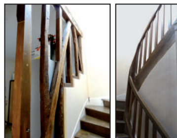
Escalier d'origine menant aux chambres, 2016
