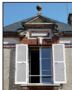
Fenêtre de l'ancien logement de l'institutrice et de l'actuel bureau du Maire, 2016
