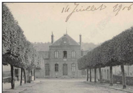
Façade sur allée, 1906 ©AD91 2Fi_081_018
