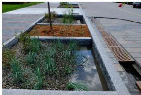
Figure 3: Nivee en pente scindée en plusieurs biefs par des murs de barrage avec un dispositif de vriage dans le quartier du Kronsberg, Hanovre, Allemagne. Source photo: Valérie Mahaut
