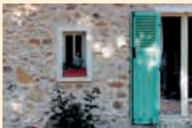
Enduit à pierre vue. ▲
