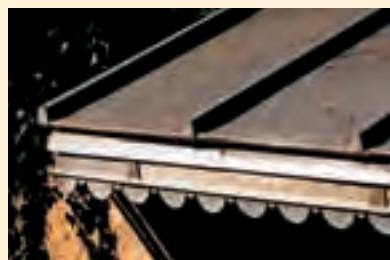
◀ Auvent en zinc d'un lavoir privé.
