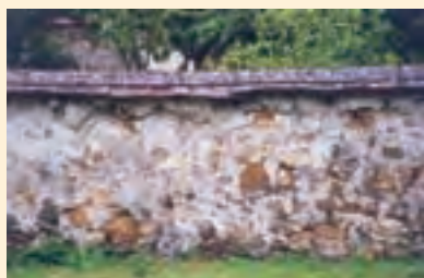
▲ Mur plein en maçonnerie de meulière.
