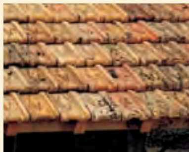
Tuile à emboîtement losangée fabriquée localement. ▶
