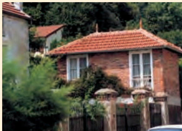
Tuile à emboîtement losangée fabriquée localement. ▶
