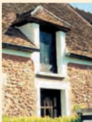
Lucarne engagée dans le mur, couverte "à la capucine".
