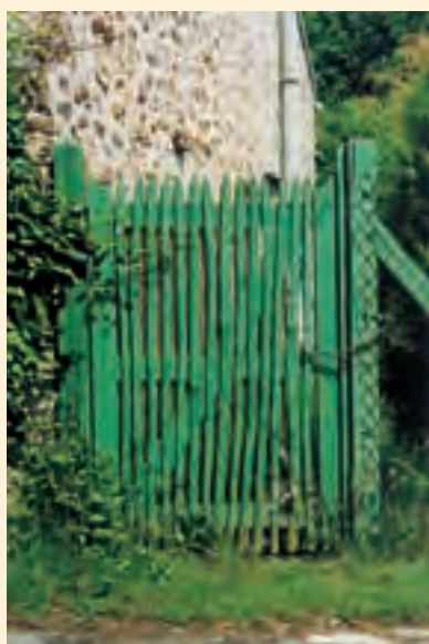
▲ Portillon en échalas de châtaignier peint. Les lames de bois espacées assurent une certaine transparence. Portes et portails peuvent aussi être en planches jointives ou en panneaux de bois qui masquent les vues.
