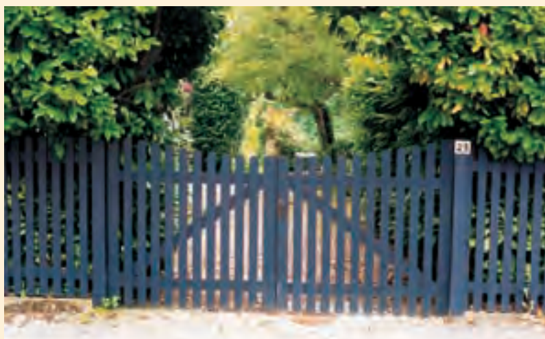
◀ Clôture basse en bois au dessin très simple. Les peintures microporeuses d'excellente durabilité permettent le choix de la teinte.
