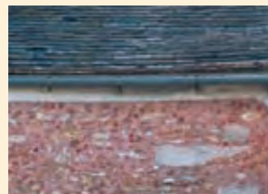
Enduit coloré à la brique pilée. ▼
