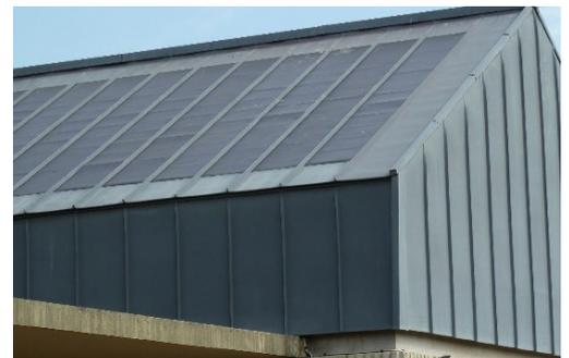
Choisir des capteurs « souples » et privilégier un bac acier dans les tons de gris pour une meilleure intégration avec la couleur des capteurs.
