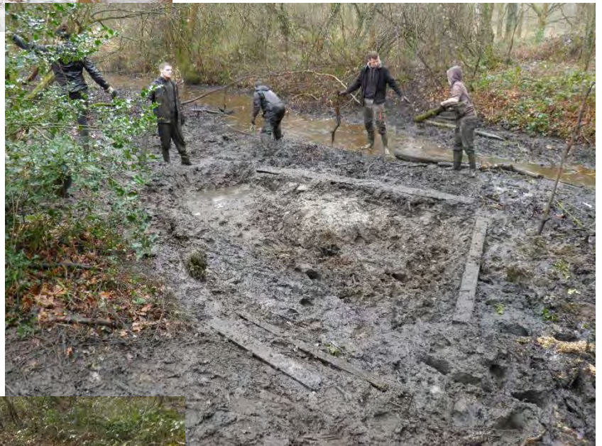
Retrait du « barrage » en fin d'intervention.
