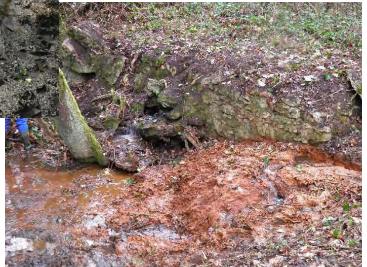
Le chantier a aussi permis de remettre en valeur l'arrivée d'eau de la rivière anglaise.
