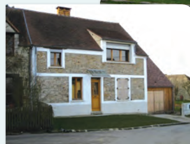
Exemples : Plusieurs conseils de restauration comme à Forges les Bains
