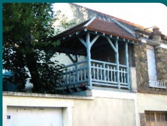
Chevreuse, restauration d'une gloriette en centre bourg (bien privé)
