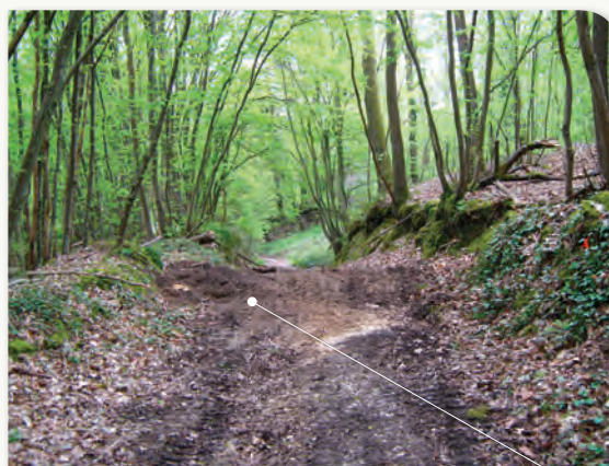
Le chemin, dans l'axe de la plus grande pente, se comporte comme un accélérateur de l'écoulement. Des talus transversaux au chemin ont donc été réalisés pour conduire l'eau dans un talweg sec naturellement empierré, jouant le rôle de dissipateur de l'énergie hydraulique.
