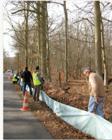
Installation de la barrière « aller »
