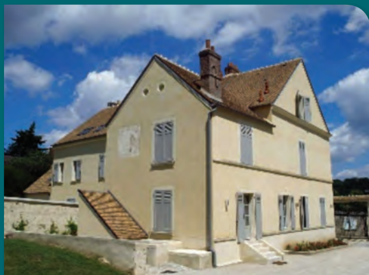
Saint-Lambert-des-Bois, ancien presbytère transformé en logements : restauration des façades
