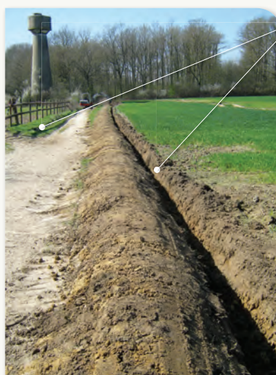
Fossés creusés afin de conduire l'eau provenant des champs agricoles en direction de mares réservoirs.
