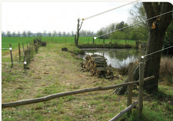
Photo de la mare et des travaux réalisés au cours de l'année 2012.
