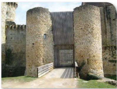
Nouveau portail en chêne sur structure acier au châtelet du château de la Madeleine à Chevreuse
