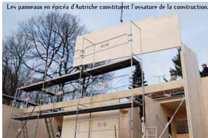
Les panneaux en épicea d'Autriche constituent l'ossature de la construction.
