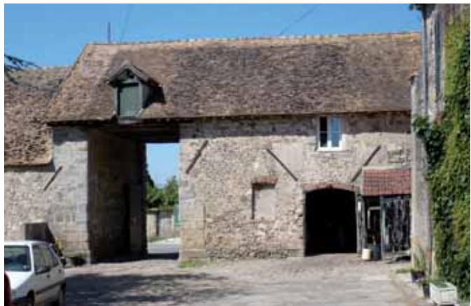
▲ Ferme de l'Église à Longvilliers
