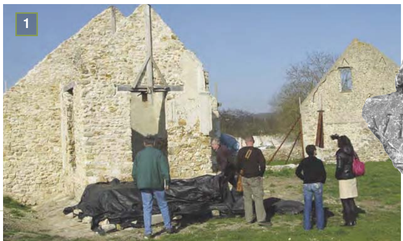
1 ■ La chapelle du XVIII e siècle dont la restauration des murs s'est achevée en 2011
