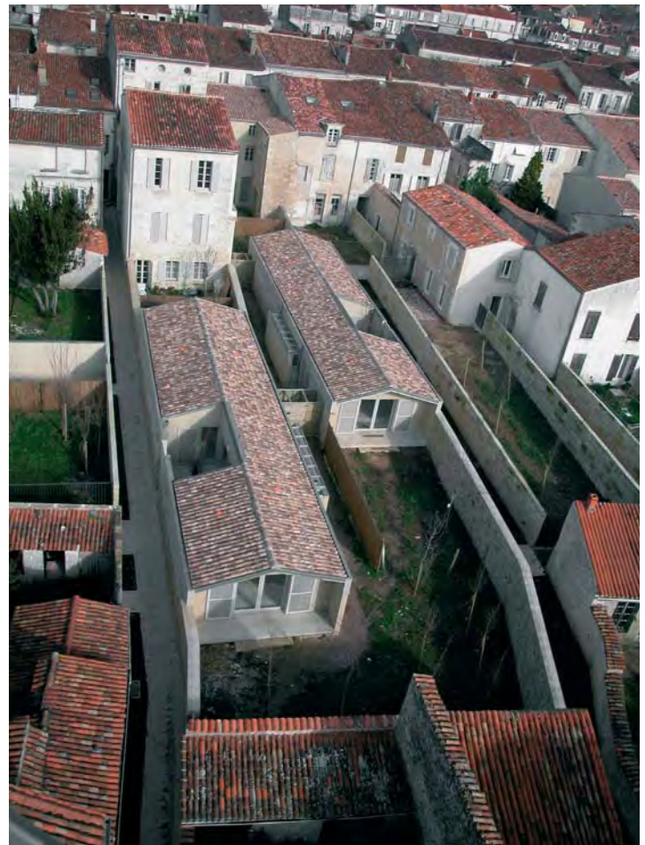
Saintes [09] : Le processus de réhabilitation et d'intervention sur le bâti insalubre du parcellaire a été effectué en lanière.
