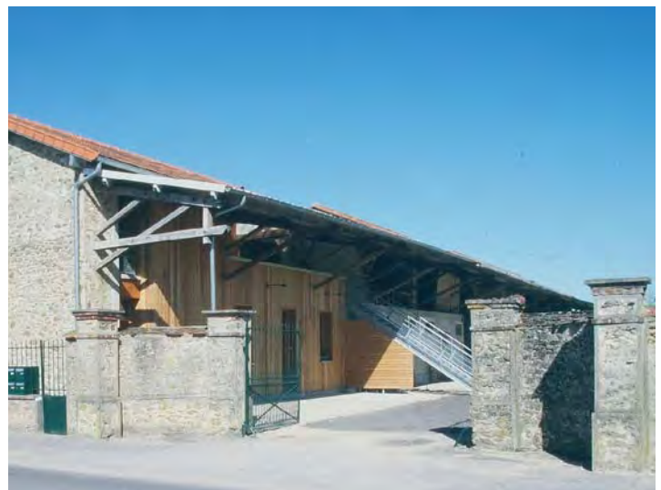
Villeneuve-le-Comte [11] : L'opération de réhabilitation respecte l'intégrité de l'ancien corps de ferme et modernise son image par un jeu de volumes internes ainsi que l'emploi de matériaux qui contraste avec les murs en pierres massives.
