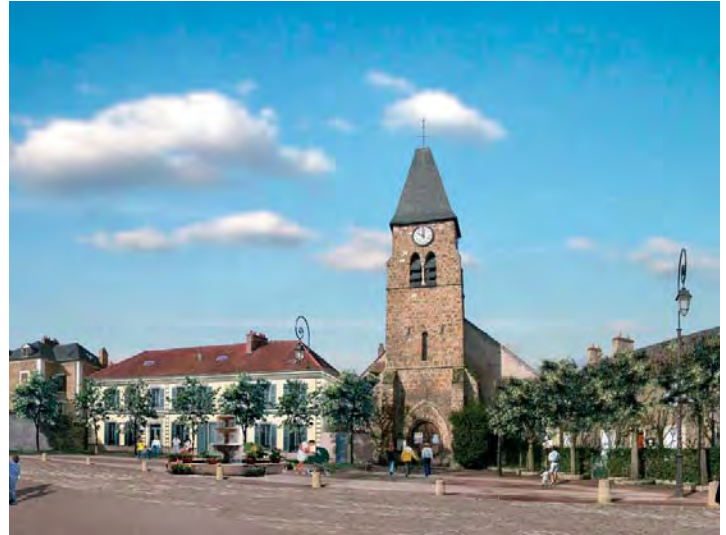
Saint-Rémy-lès-Chevreuse [01] : La place de l'Eglise est dégagée par la démolition de deux anciens bâtiments et donne une cohérence à l'ensemble.
