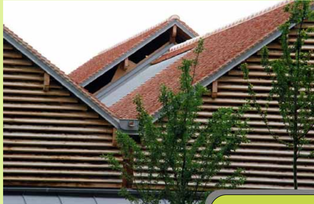
Capteurs entre deux toits
