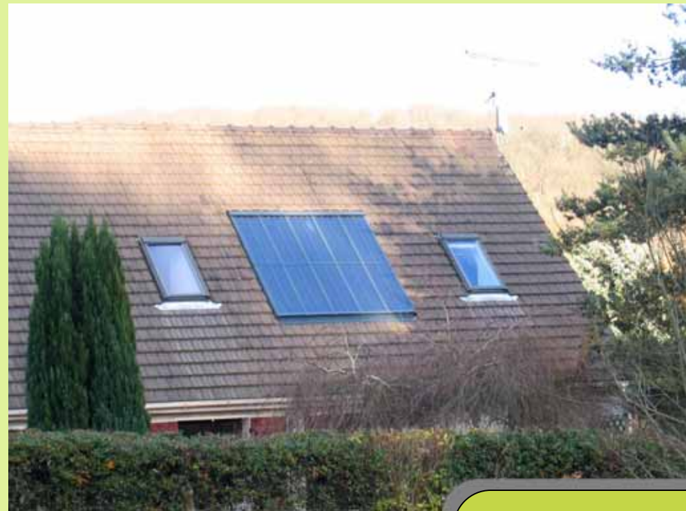
Maison à Chevreuse
