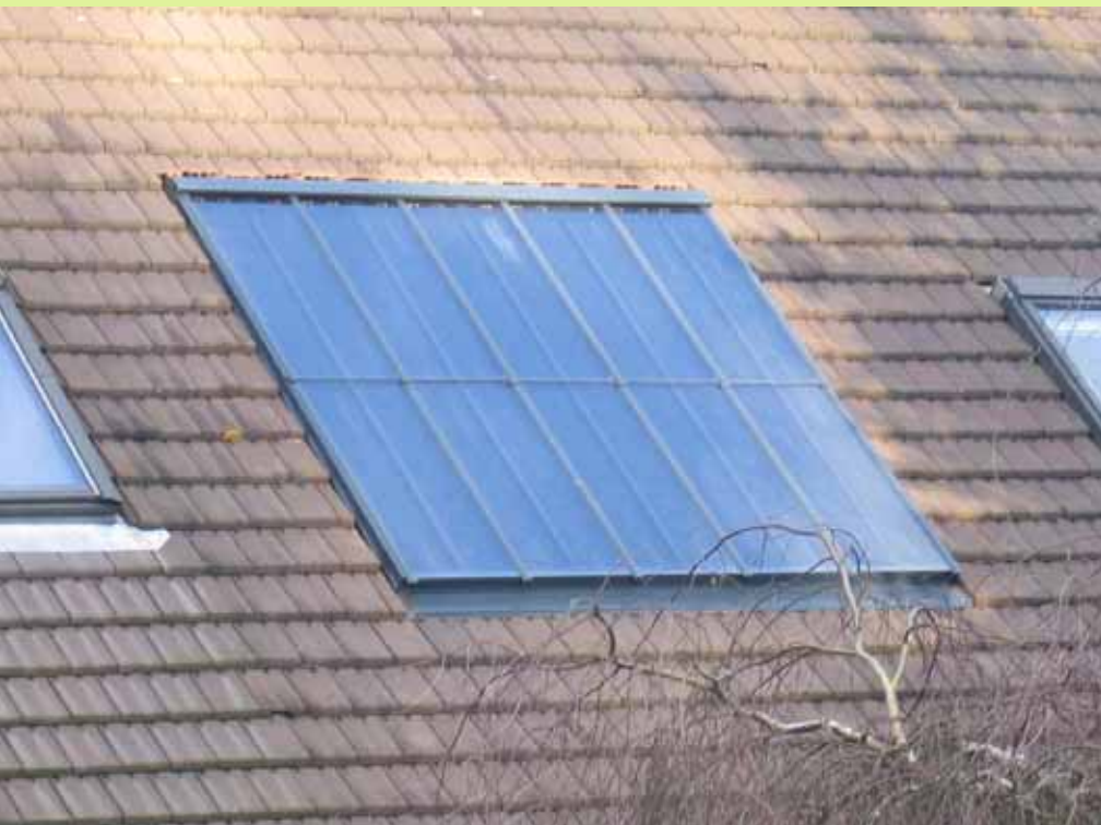
Maison à Chevreuse
