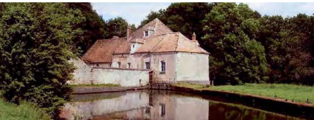
Le moulin Neuf de Saint-Arnoult a conservé son bassin de retenue maçonné qui alimente la roue, toujours en place.
