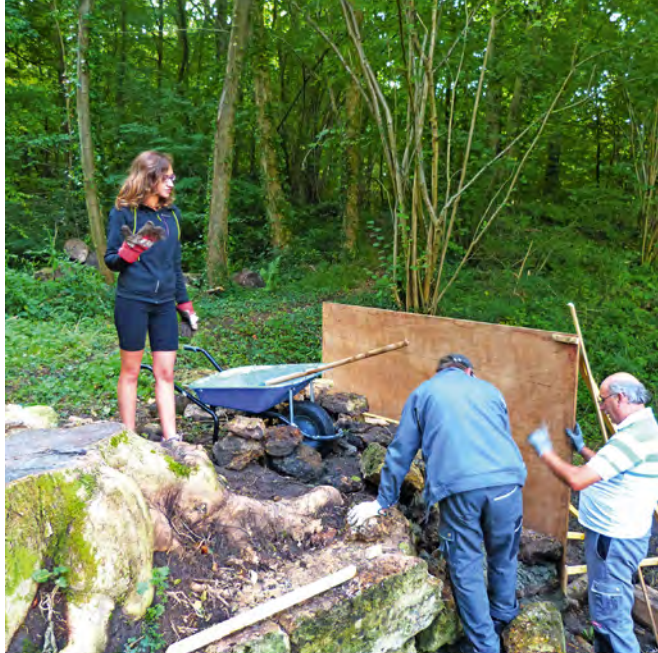
Remise en état d'une digue
