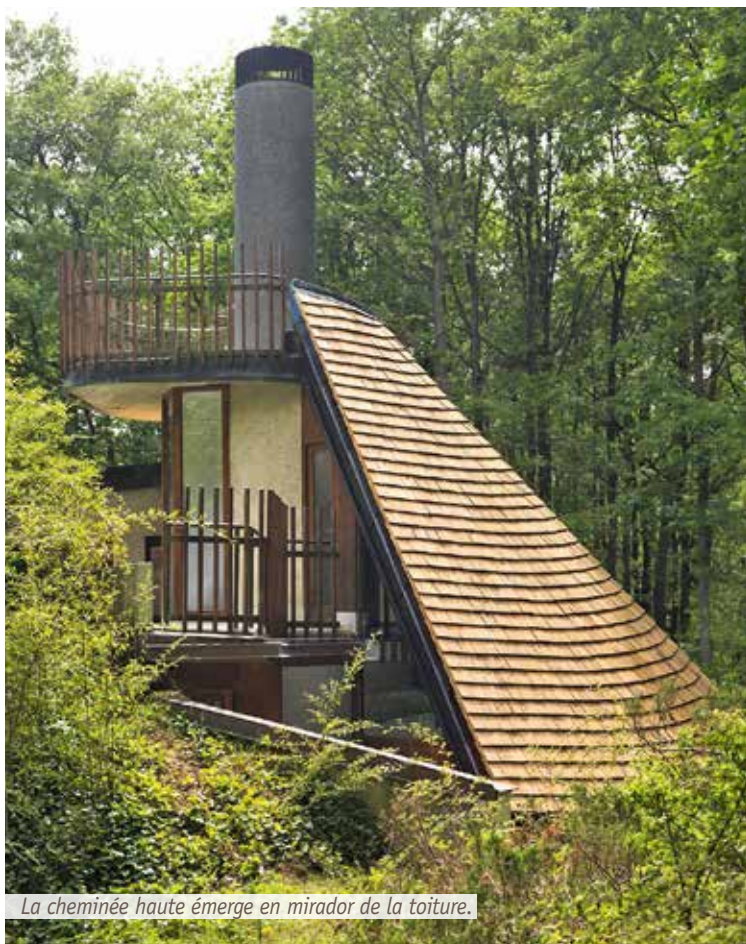
Un toit en tavaillons de châtaignier.
