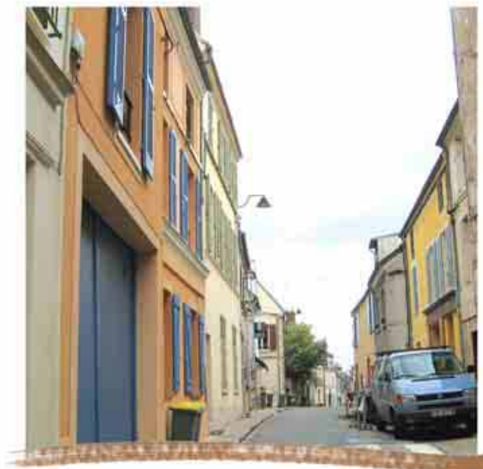
Ces rénovations de façades réalisées avec l'aide de l'OPAH égayent la rue de Paris à Chevreuse.
