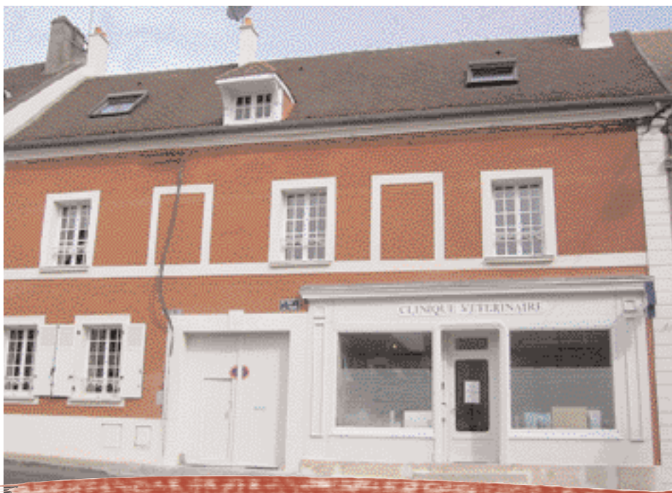
▲ Avant et après travaux : les fausses fenêtres rééquilibrent le dessin de façade et le décor est restitué par les contrastes de couleur ▼
