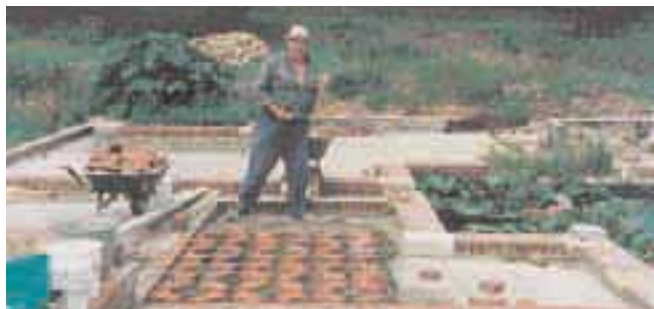
Le maçon Jacques Di Gallo a consacré plus de 17 500 heures au chantier du jardin d'eau.
