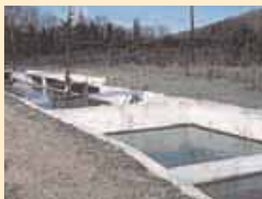
▲ Station d'épuration, désablement
