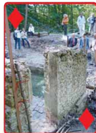
Conseils, visites de terrain, ingénierie, ici sur un lavoir en restauration.
