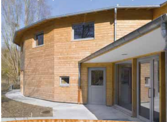
Ossature et bardage bois, isolation en ouate de cellulose, chauffe-eau solaire, le foyer d'Ulysse à Bullion a reçu la certification HQE.
