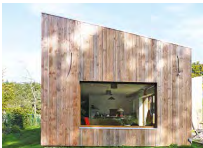
Des murs garnis de paille, préfabriqués en atelier pour une installation en une semaine
