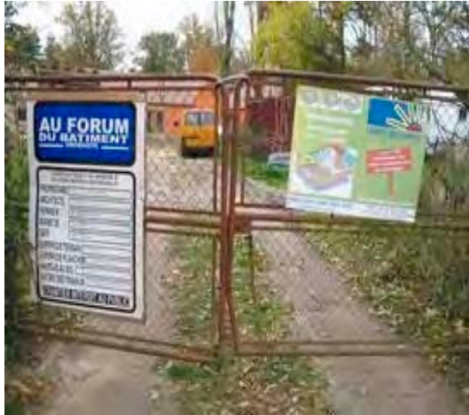
Un chantier comportant une installation géothermique - La Hauteville - M. Bourgeois/IAURIF
