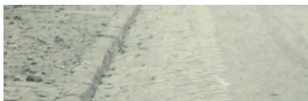
Dispositif bordure/caniveau en grès
