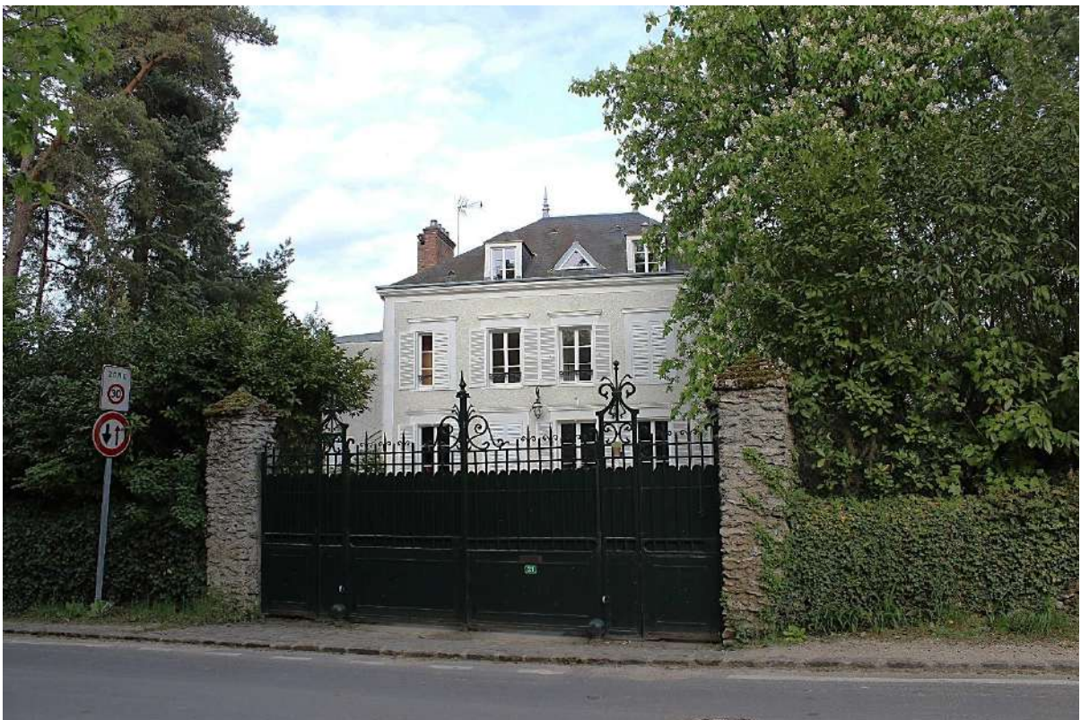
Maison de notable du 21 rue de l'Eglise, 2018
