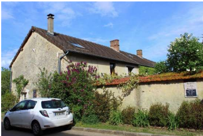
Ferme du 1 rue de l'Eglise, façade sud (en haut) et nord (en bas), 2018
