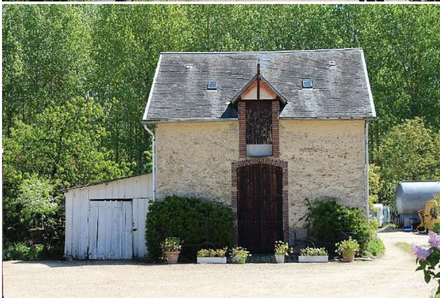
Ferme du 63 route d'Épernon (Amblincourt) : logis, étable et écurie, 2018
