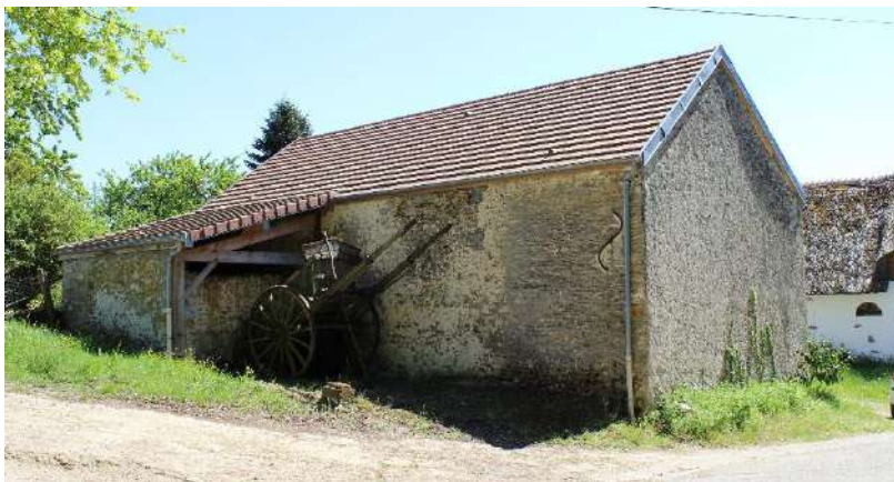
Grange du Gros Taillis, façade nord, 2018
