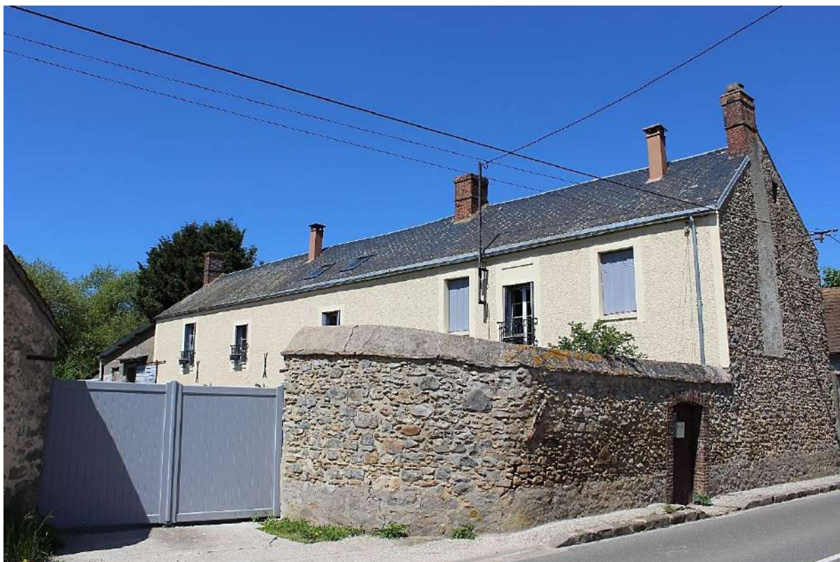
Ferme du 52-54 route d'Épernon, corps de bâtiments principal, 2018
