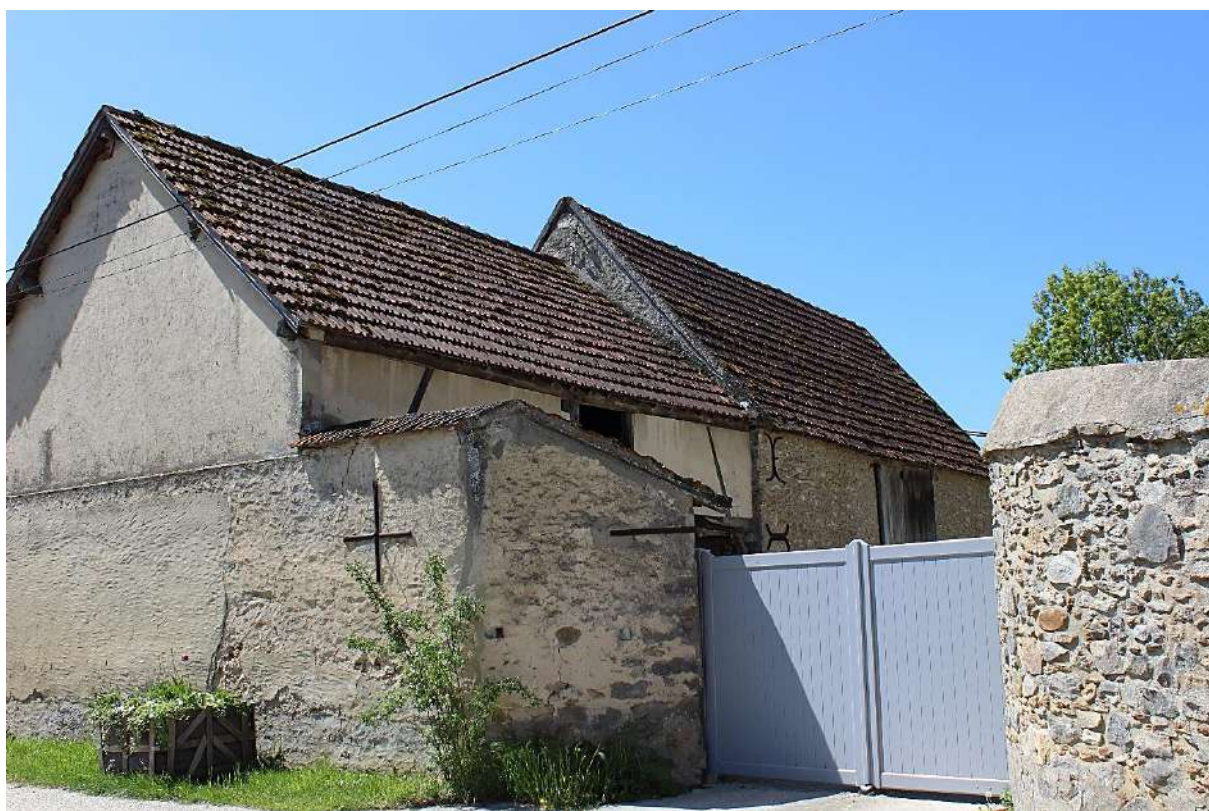
Ferme du 52-54 route d'Épernon, corps de bâtiments secondaire, 2018
