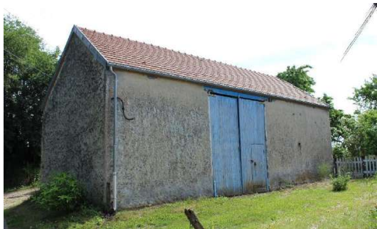
Grange du Gros Taillis, façade sud, 2018
