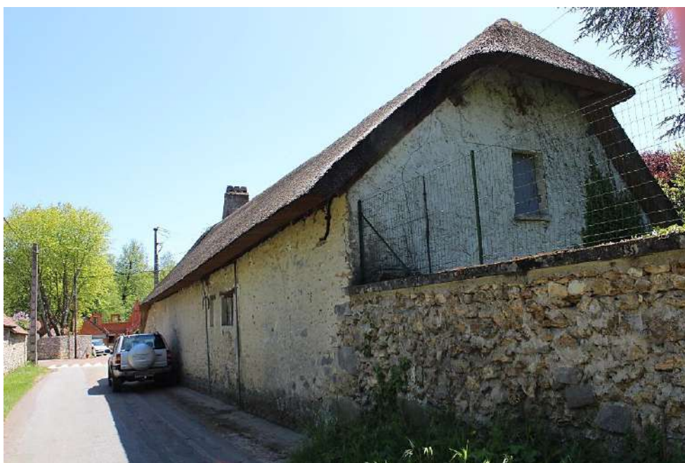
Maison rurale du 18 route d'Épernon, pignon ouest, 2018
