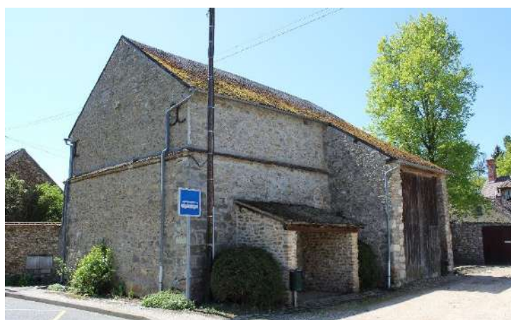
Grange du 26 route d'Épernon à Amblincourt, façade nord, 2018
