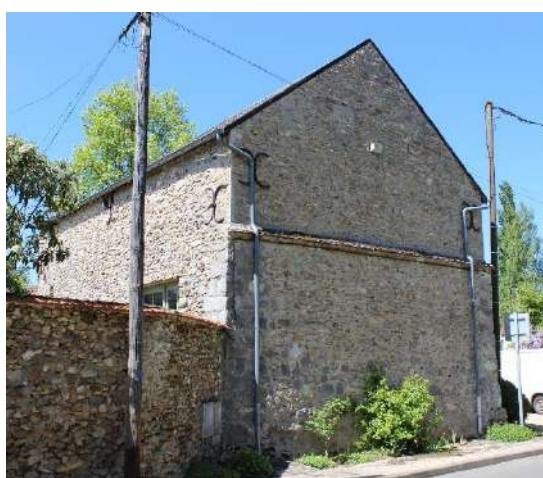
Grange du 26 route d'Épernon à Amblincourt, façade sud et pignon est, 2018
