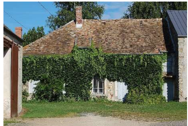
Bergerie, état avant rénovation, 2012
