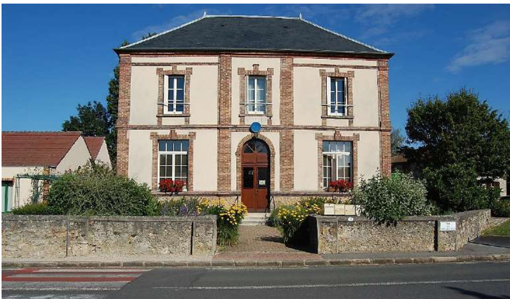
Façade avant de la mairie-école, 2012
