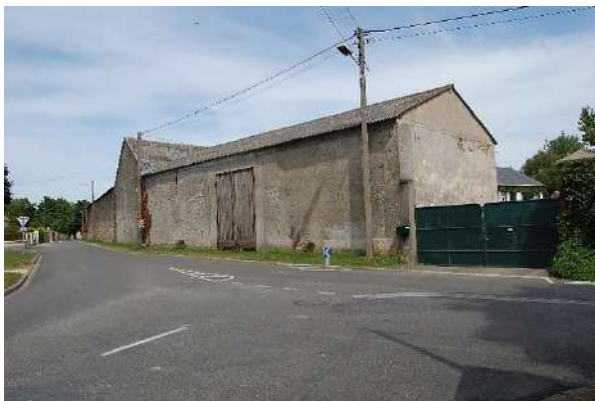
Vue sud de la grange, 2012
