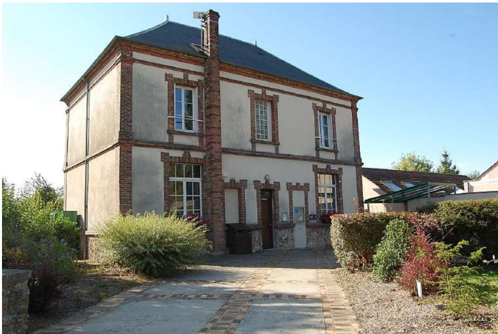
Façade arrière, côté cour d'école. On distingue au rez-de-chaussée trois portes : l'ancienne porte de la classe (à gauche), celle de la mairie (au centre) et une fausse porte dessinée par souci de symétrie (à droite), 2012
