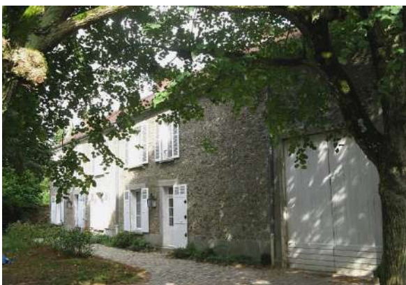
Façade sud de la ferme, 2008 ©Kargo
