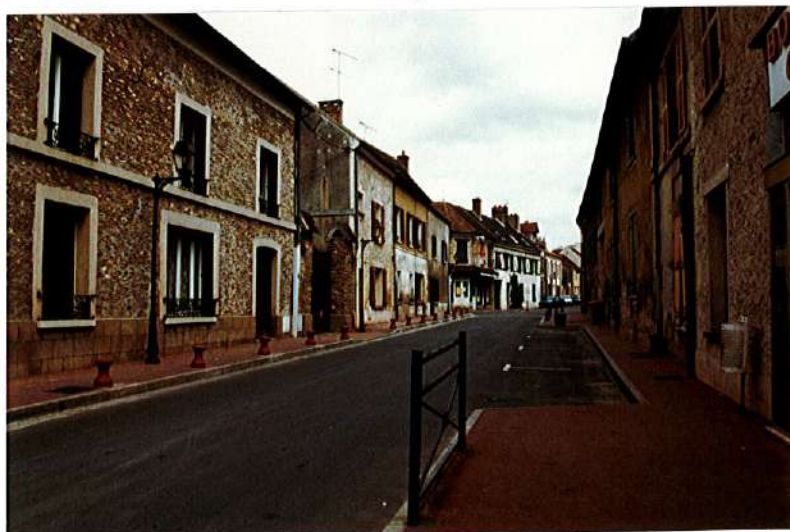
Aménagement - Rue de la Division Leclerc
